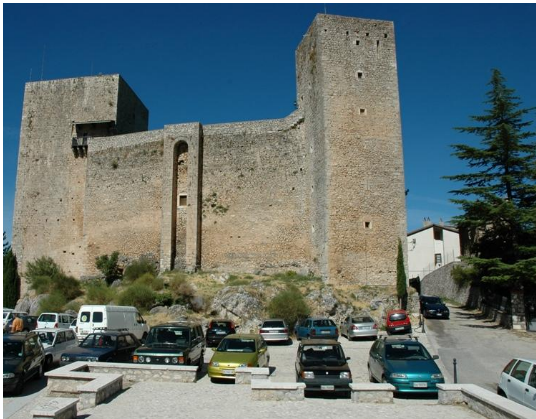
Figura 1 - Muretti su Largo castello
