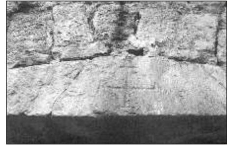
Fig. 4. Pereto: segno lapidario sull'architrave dell'ingresso al mastio.
