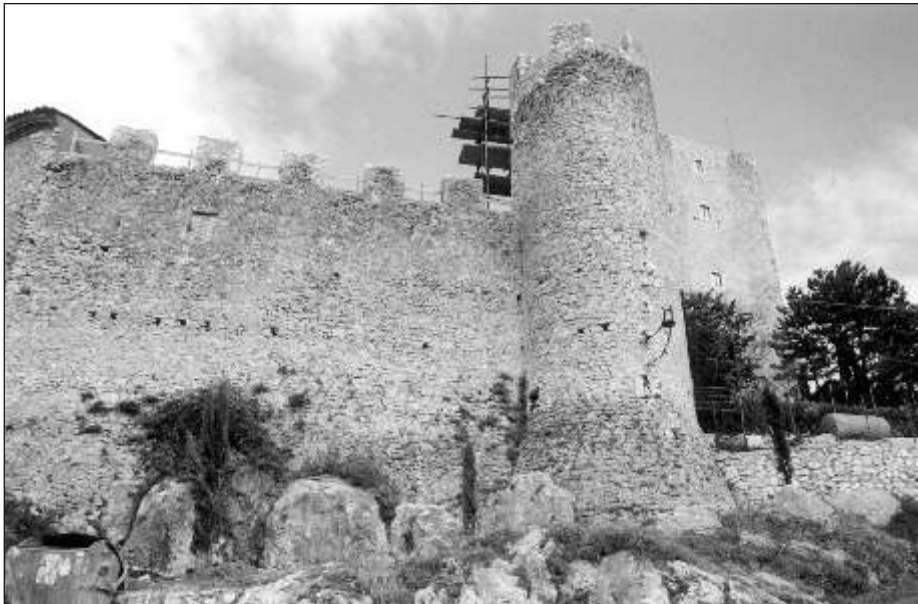
Fig. 7. Pereto: torre angolare e mura del tratto sud-ovest durante i restauri.
