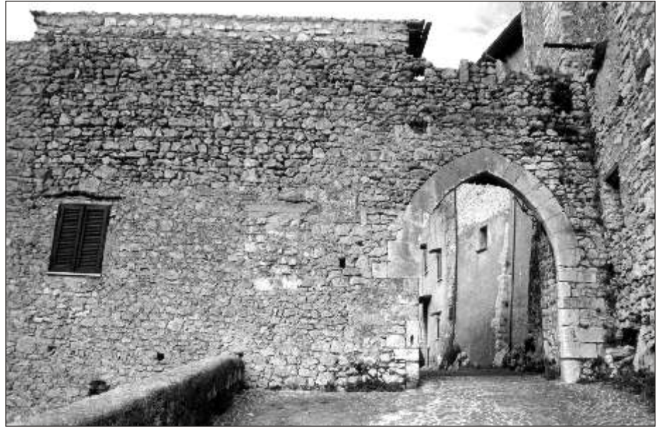
Fig. 6. Pereto: porta Matticca prima dei restauri.
