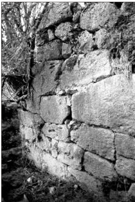
Fig. 5. San Pietro , muro in opera poligonale.
