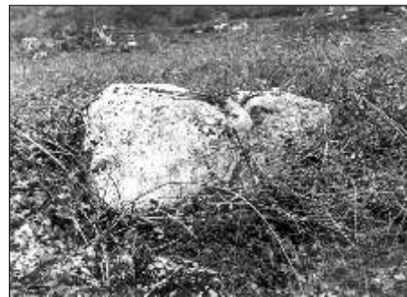
Fig. 8. Pereto: località u' Pastinu, resti di muro in opera poligonale, forse del III tipo.
