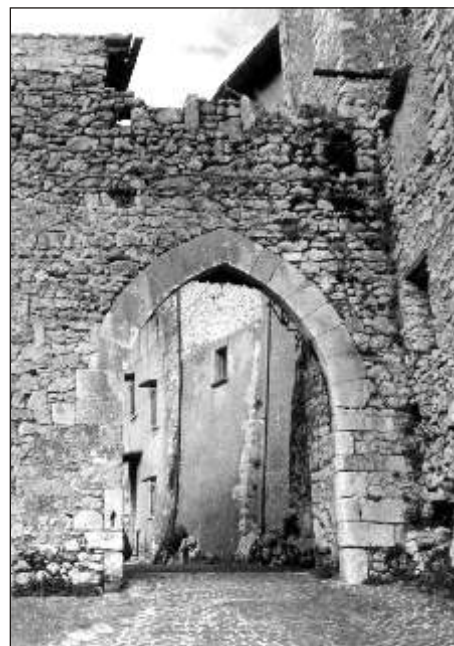
Fig. 6. Pereto: porta Matticca prima del restauro.
